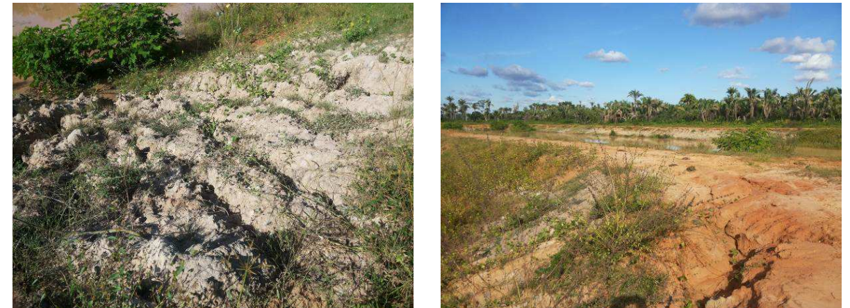
Figura 21 – ETE Timon - inacabada
