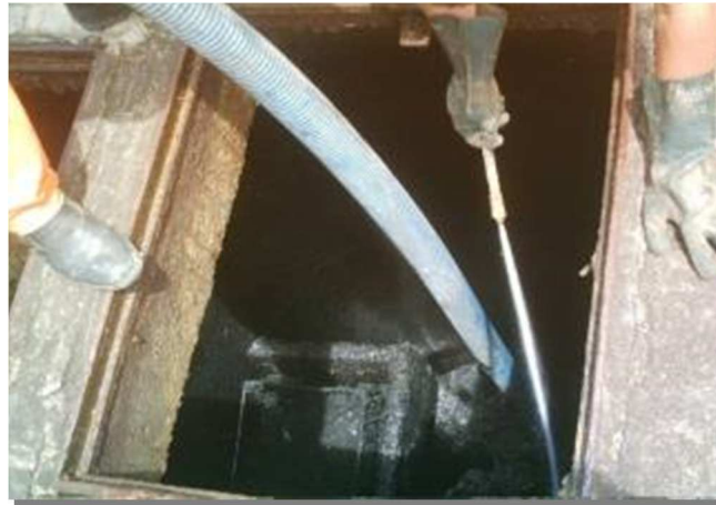
Figura 31. Jateamento e succionamento em fosso de elevatória de esgoto
